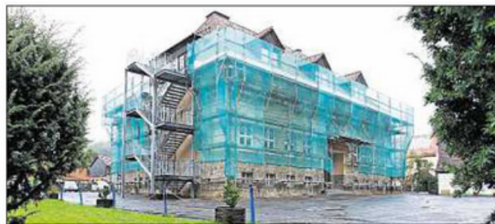
Vor gut einer Woche begannen die Arbeiten am Schulgebäude. Die Fassade wird ausgebessert und erhält einen neuen Anstrich.
